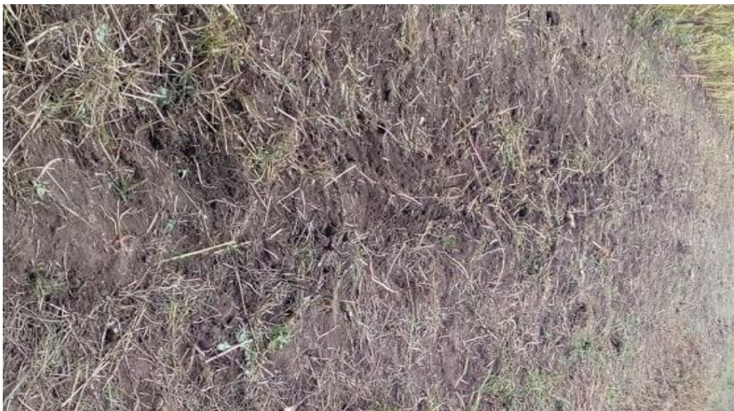
Imagen 15. Preparación del Terreno.
